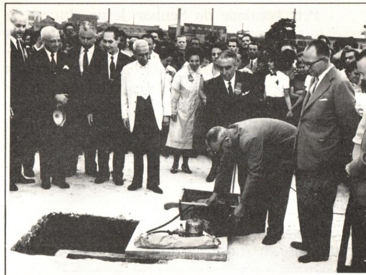
Lançamento da pedra fundamental, ocorrido no dia 25 de Janeiro de 1960.
